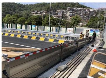
图3-7 固定式铝合金挡水板
