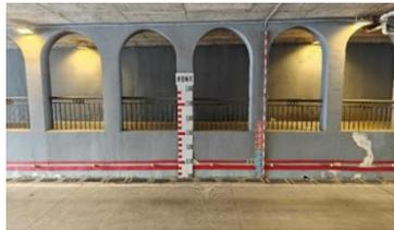
图3-5 下穿通道积水标识线
