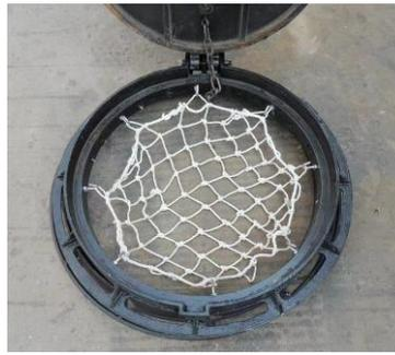
图3-9 防坠网、防坠隔板改造
