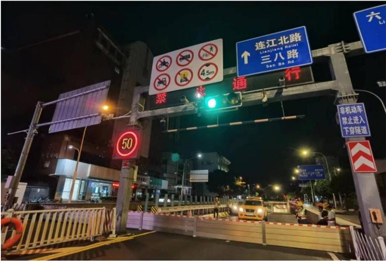
图4-8 封闭下穿通道，设置挡水板
