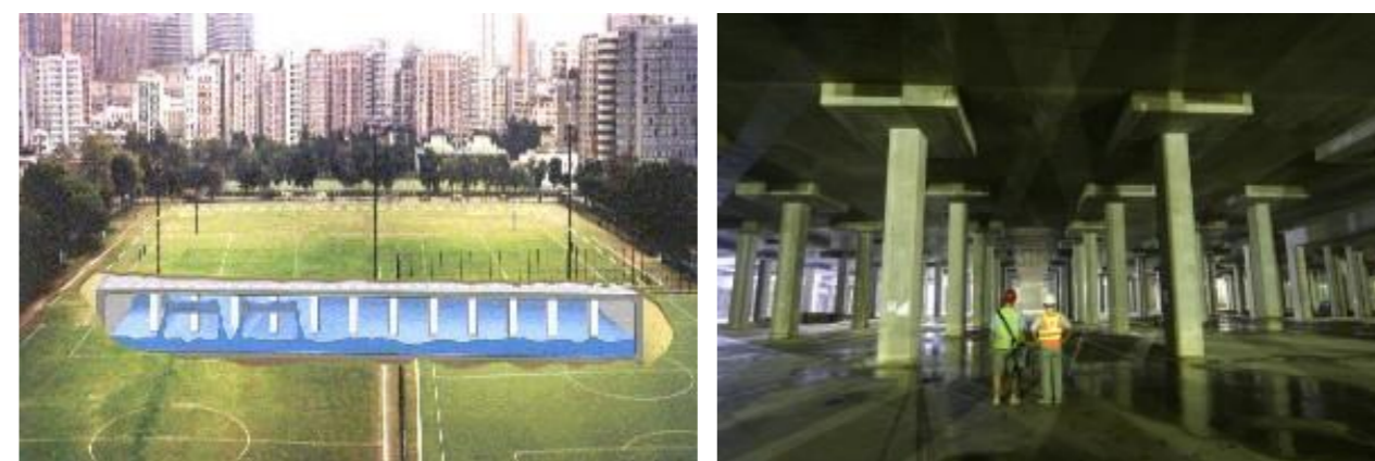
图 4.1-5 大坑东蓄洪池
